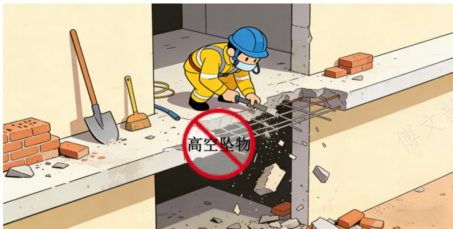
5.拆除梁或悬挑构件时，未采取有效防止拆除物坠落的措施。
