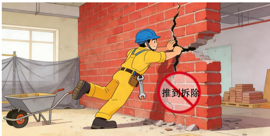
3.人工拆除建筑墙体时，采用底部掏掘或推倒的施工方法。
