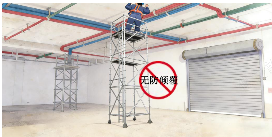
4.移动操作平台未与建筑物进行刚性连接或设置防倾覆措施，操作平台四周未按规定设置防护栏杆或未设置登高扶梯，基础存在不平整或未夯实、硬化。
