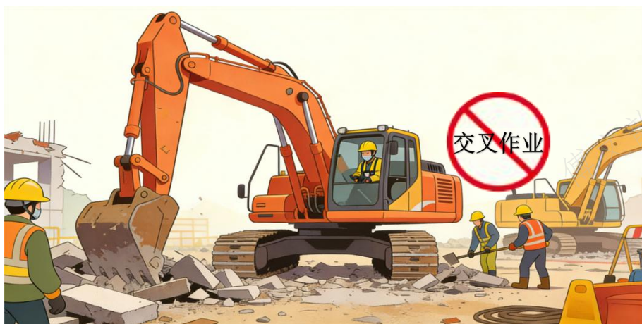
9.机械拆除需人工拆除配合时，存在人员与机械在同一作业面上同时作业未采取安全措施。
