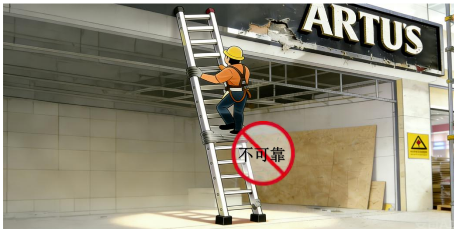
6.当梯子接长使用时，接头超过 1 处，且连接措施不牢固；使用折梯时未设置铰链或可靠拉撑装置。
