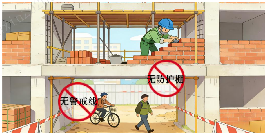
9.垂直交叉作业未采取可靠安全防护措施（设置防护棚），下方未设置警戒区域，或未安排专人监护，无关人员能随意进入。
