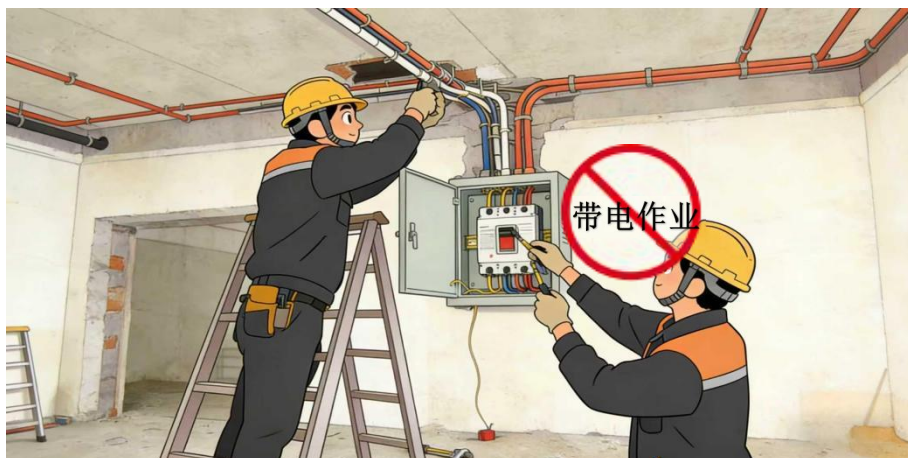
3.室内机电管线拆除改造作业时，未切断户内正式配电箱总开关。
