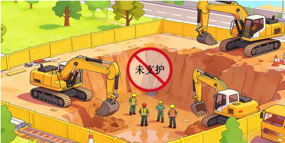
6. 有围护支撑的基坑开挖时未遵循“开槽支撑、先撑后挖、分层开挖、严禁超挖”原则，存在一次开挖到底的情形。
