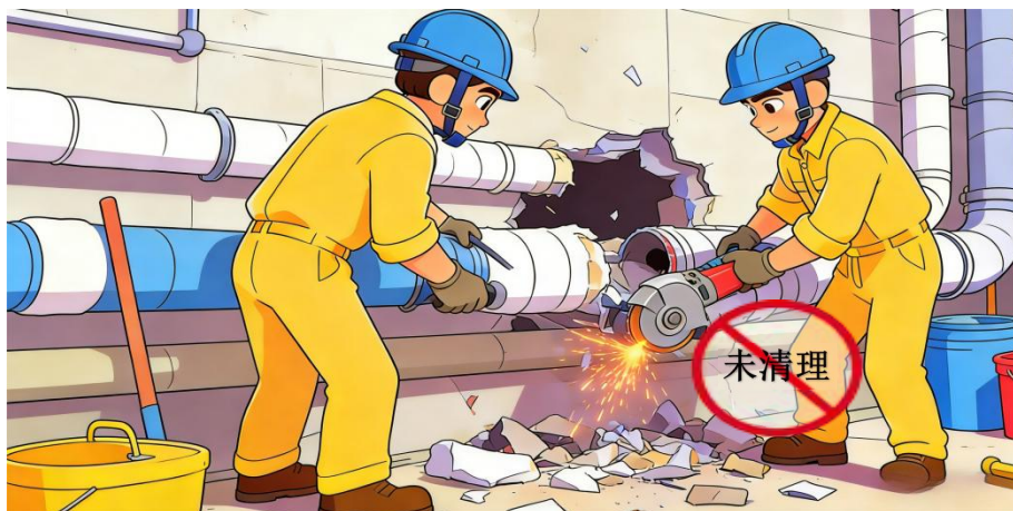
7.涉及拆除管道或容器时，未查明残留物的性质就进行拆除施工；管道有保温材料时，未清理保温材料进行切割拆除。
