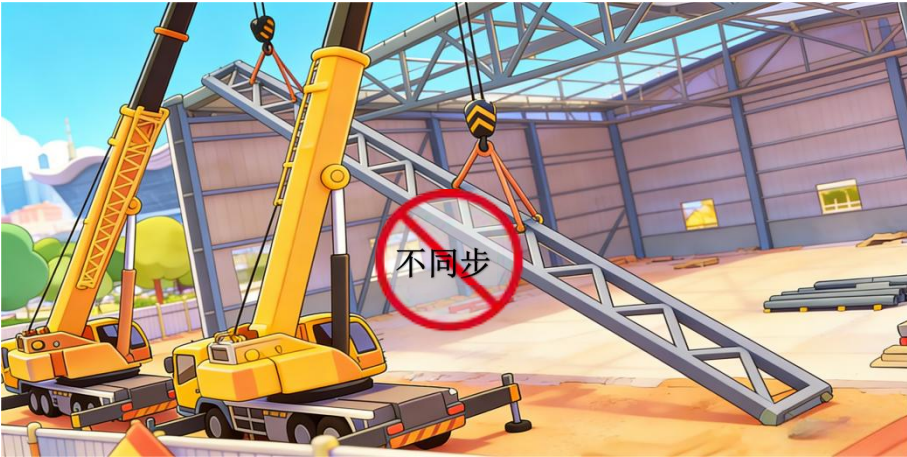
9.多台起重机械联合作业时，未明确指挥协调人员，各机械动作不同步。
