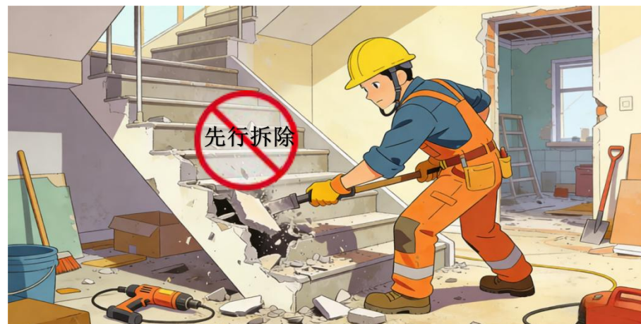
8.拆除建筑的栏杆、楼梯、楼板等构件时，未与建筑结构整体拆除进度相配合且先行拆除。
