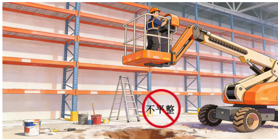
7.曲臂式升降机、剪叉式升降机、升降平台等高空作业升降设备作业时场地不平稳或存在超载情形或设备安全装置失效。
