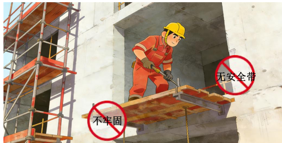
3.悬空作业未设置牢固的立足点，未配置登高和防坠落的安全设施。
