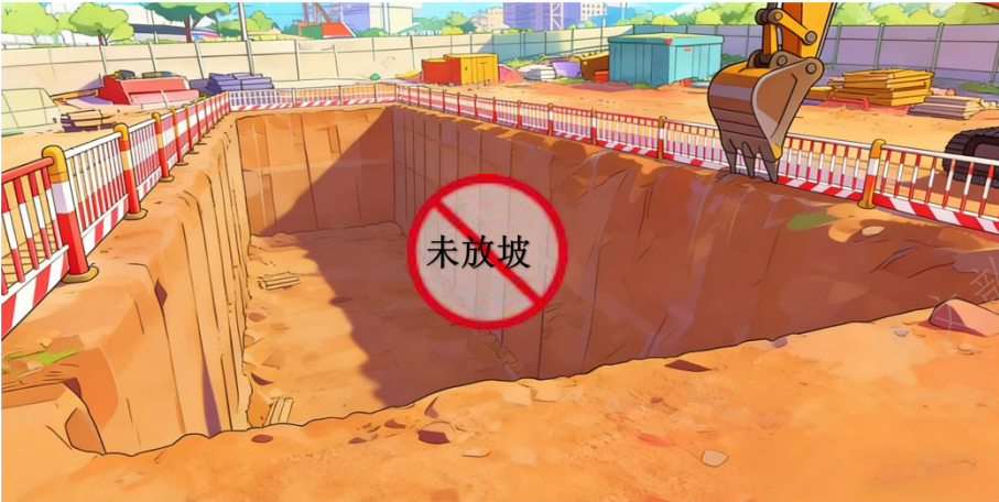
7. 放坡开挖的基坑未按照图纸要求进行开挖，且开挖后未及时修整边坡、护坡；未在基坑顶外侧设置截水沟，未在基坑底设置排水沟和集水井。
