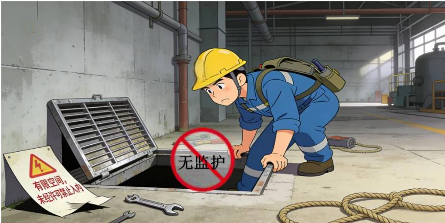
4.有限空间作业时现场无专人负责监护工作，或无专职安全生产管理人员现场监督，或存在监护人中途离岗，监护人员未每隔 30 分钟如实记录一次过程检测结果。
