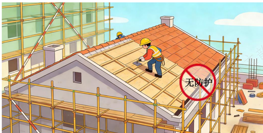
8.斜屋面檐口未设置临边防护或防护高度低于 1.5m，且未采用密目式安全立网进行全封闭。
