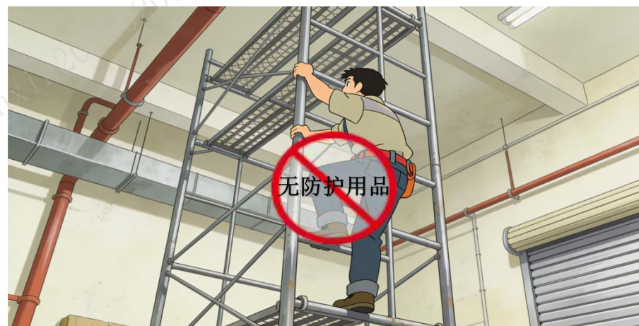
5.登高作业人员未正确佩戴安全帽、安全带等个人防护用品；安全带未高挂低用或挂设点不牢固等情形。
